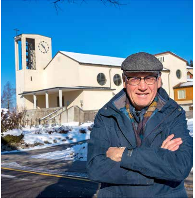
Der Entlebucher Kirchgemeindepäsident Pius Hofstetter vor der Kirche Finsterwald, die mit einer Solaranlage ausgerüstet wird. Das ist dort möglich, weil der Bau nicht denkmalgeschützt ist.
